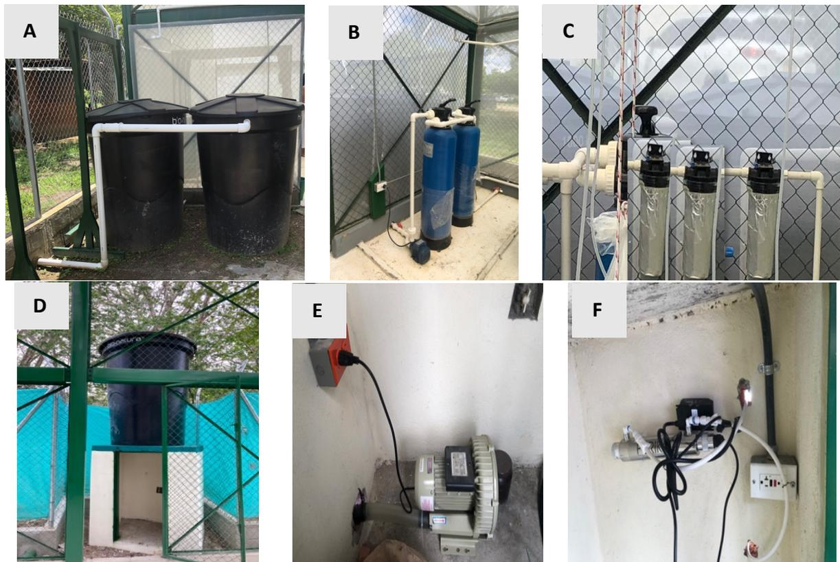
Figura 10. A) Tanques de copio de agua. B) Filtro de carbón activado y zeolita. C) Filtros millipore 25  $\mu\text{m}$ , 5.0  $\mu\text{m}$  y 1.0  $\mu\text{m}$ ; D) Almacenamiento de agua purificada; E) Compresor de aire de 0,5 hp; F) Filtro ultravioleta (Foto original Vallejo-Isaza).
