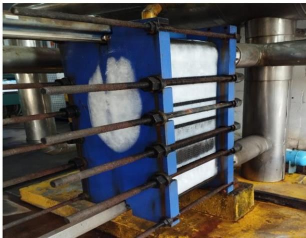
**Figura 5.** Intercambiador de placas para glicol de la planta RED CÁRNICA.
