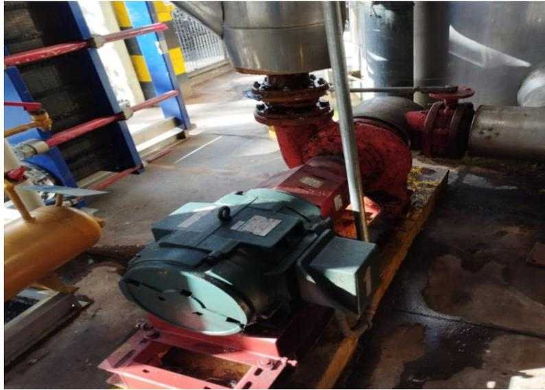
**Figura 8.** Bomba de glicol GRUNDFOSS NK 80 de la planta RED CÁRNICA.
