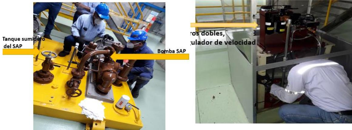
**Figura 14.** Mantenimiento sistema SAP, regulador de velocidad.
