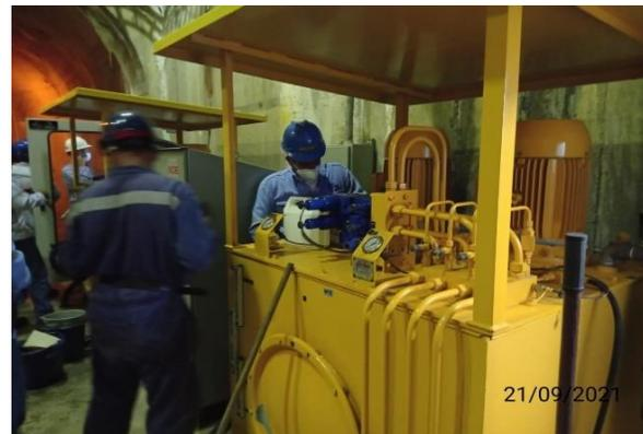
**Figura 9.** Mantenimiento compuerta descarga de fondo.
