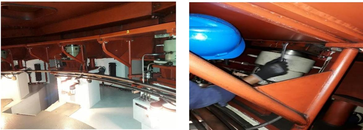
**Figura 13.** Apriete, pernos del sistema de frenado.
