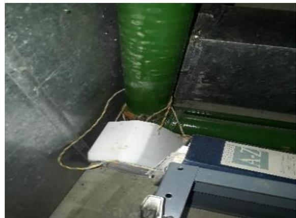
**Figura 4.** Corrosión en tubería de distribución de agua de servicio
