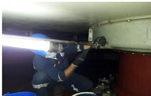
**Figura 12.** Sistema Hidráulico, distribuidor de la turbina.
