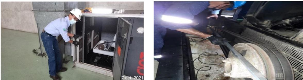
**Figura 6.** Limpieza de rejillas de ventilación y nivelación de poleas.
