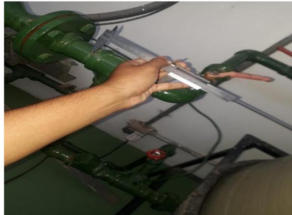
**Figura 15.** Medición de tubería del tramo casa de máquinas.
