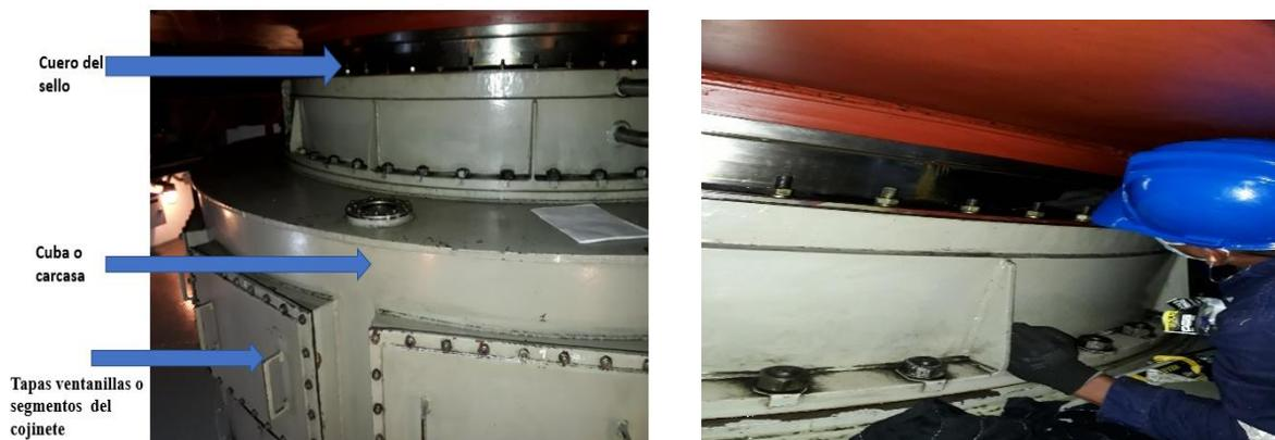
**Figura 10.** Cojinete de empuje del generador.
