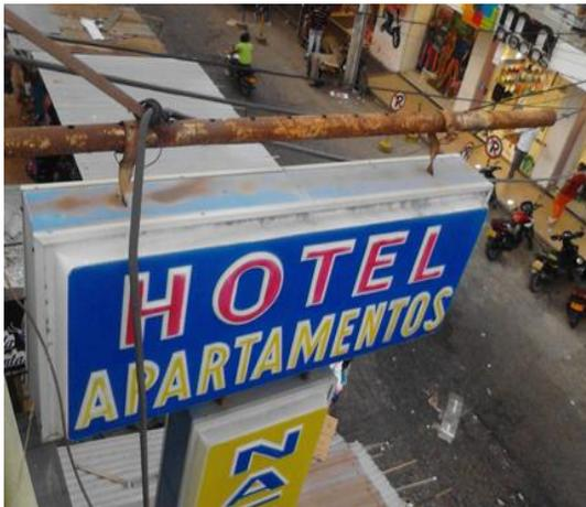
**Figura 6.** Aviso luminoso con soportes corroídos.
