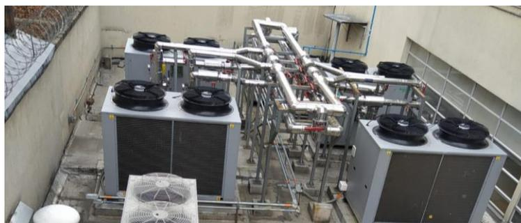
Figura 4. Sistema Chiller, Unidades Condensadoras.
