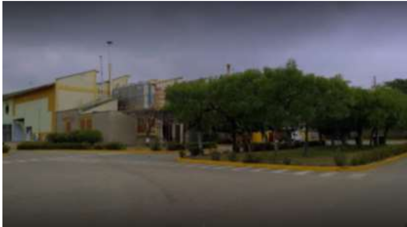
Figura 11. Empresa Frigosinú S.A. Montería.
