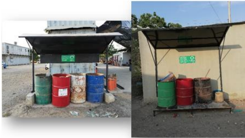
Figura 2. Mejoras de infraestructura interna. Fuente: Los autores
