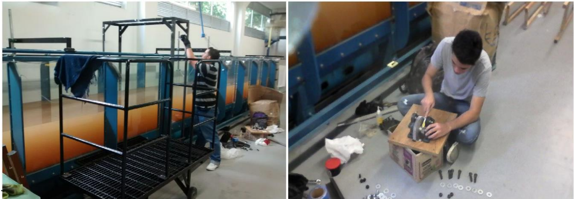
Figura 23: En la izquierda: Instalación de la estructura soporte. En la derecha: Ensamble del sistema mecánico.
