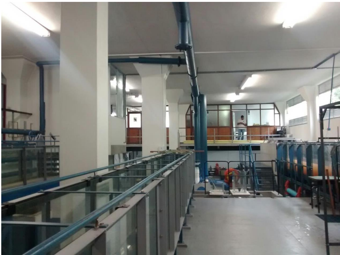
Figura 22: Instalaciones del Laboratorio de Hidráulica y Mecánica de Fluidos de la Universidad Nacional de Colombia sede Medellín.
