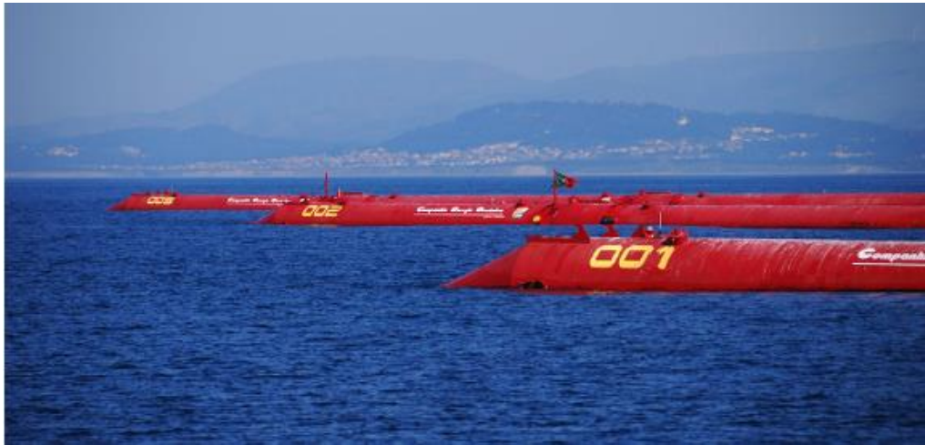
Figura 10: Tres unidades del sistema pelamis (750 kW) en el mar de Portugal Fuente: Falcão A. (2010) p. 909
