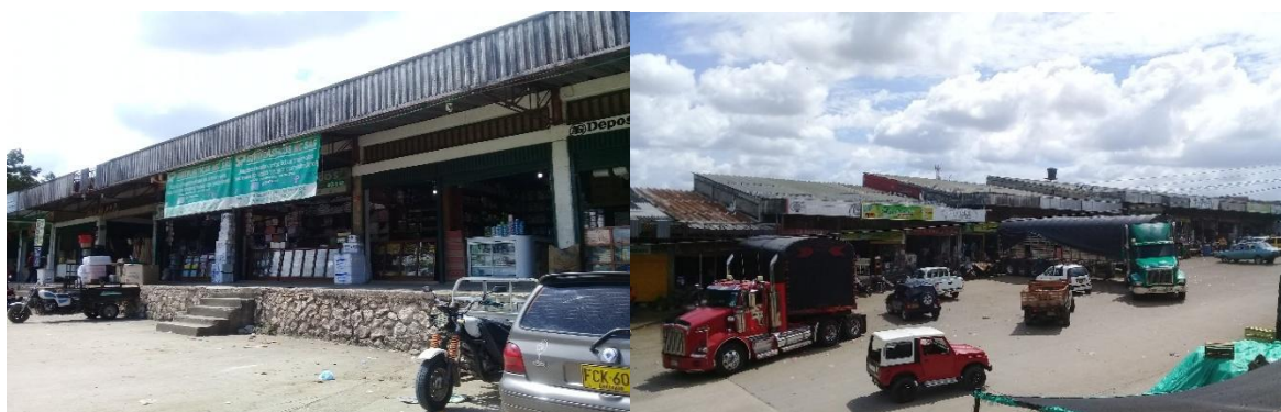
Figura 23. Locales comerciales y transporte y descargue de productos del Nuevo Mercado de Sincelejo Propiedad Horizontal. Fuente: propia tomada en campo, 2019.
