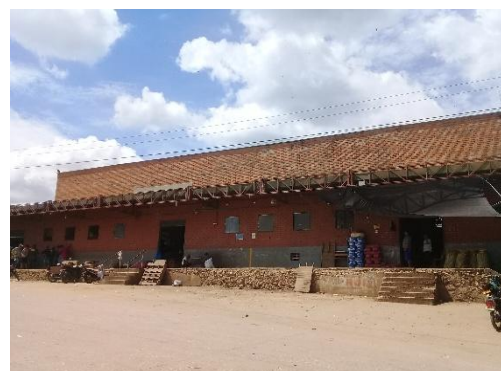
Figura 40. Nuevo Mercado de Sincelejo Propiedad Horizontal. Fuente: propia tomada en campo, 2019.
