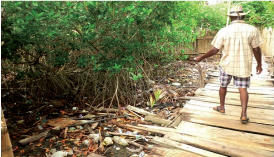
Figura 39. Fotografía de puentes construidos con la madera del manglar en Rincón del Mar. Fuente: archivo particular del equipo de investigación de la Universidad de Córdoba. Trabajo de campo, 2014.
